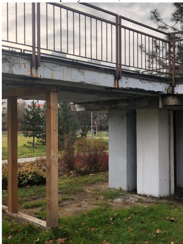
Obr. 12 - Podepřený nadchod, Dubina – hlavní třída
